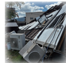
《エアコン室外機と共に崩壊》
